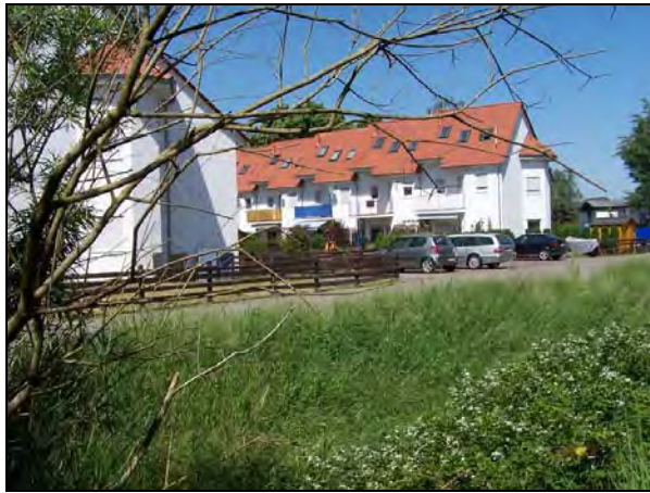
Blick über den Graben (von Südost) auf die Reihenhaussiedlung nordwestlich des Plangebietes
