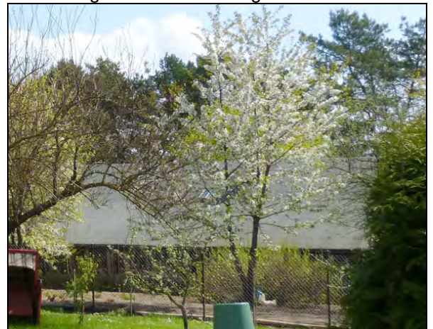
nahezu grenzständiges Wirtschaftsgebäude der Wohnbebauung östlich des Plangebietes, Blick vom Plangebiet in Richtung Ost
