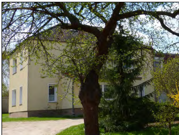
Wohngebäude, Ansicht von Nordost
