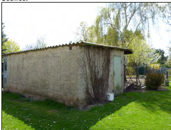
Hühnerstall, Ansicht von Nordwest
