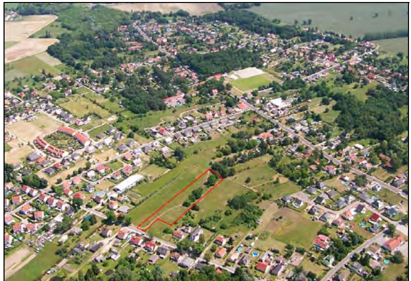
Schrägluftbildaufnahme 2010 mit Kennzeichnung des Plangebietes Aufnahme aus Südwest
