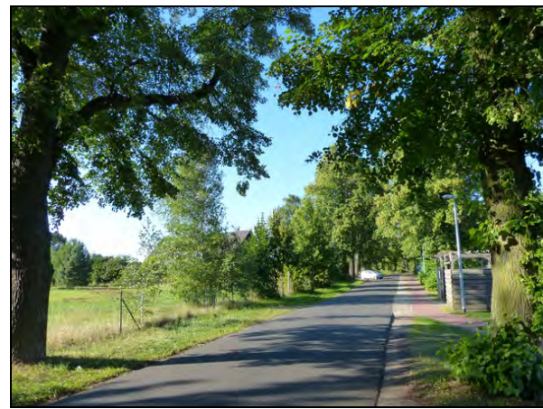
Im mittleren und nördlichen Teil der Straßengrenze des Plangebietes ist der Altbaumbestand unterbrochen, sodass hier eine Zufahrt zum Plangebiet angeordnet werden kann, ohne in den Straßenbaumbestand einzugreifen.
