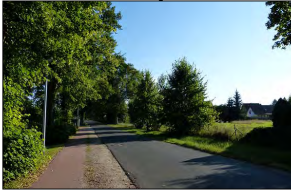
Lindenweg, Blick von Nord, im mittleren und nördlichen Teil es Plangebietes ist der Altbaumbestand der Lindenallee unterbrochen, hier sind einzelne Bäume in Naturverjüngung aufgewachsen (Linde, Birke).
