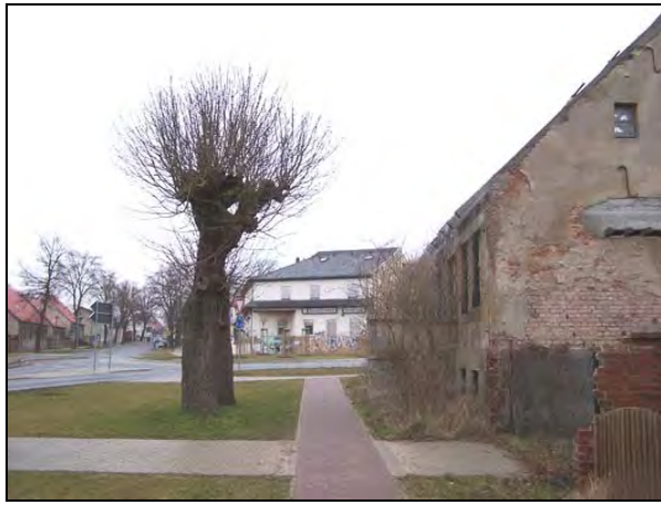
Wohnhaus-Ruine an der Grundstücksgrenze zur L17
