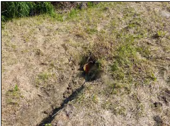
Regenwasserableitung von südlichen Nachbargrundstücken in das Plangebiet
