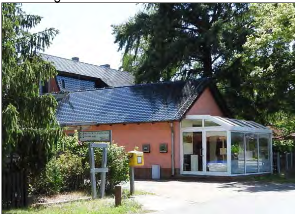
Wohn- und Geschäftshaus (Metallbau und Blitzschutz) an der Hauptstraße südlich angrenzend an das Plangebiet
