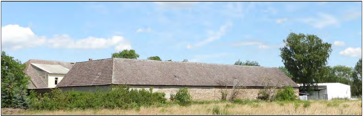
Blick vom Plangebiet nach Nord zur Bebauung der ehemaligen BHG
