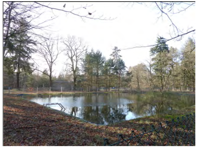
Löschwasserteich, Ansicht von Nordost
