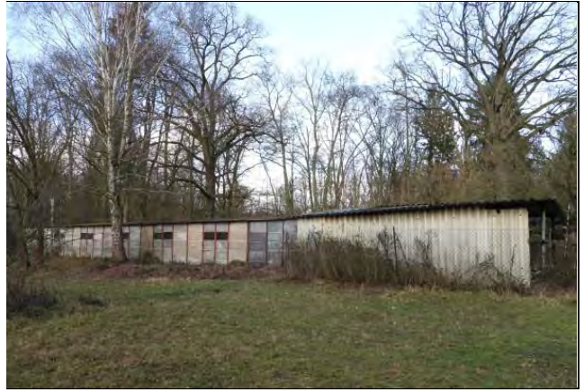
Nebengebäude hinter der Orangerie, Ansicht von Südwest (von der geplanten Stellplatzfläche, Teilfläche 2)
