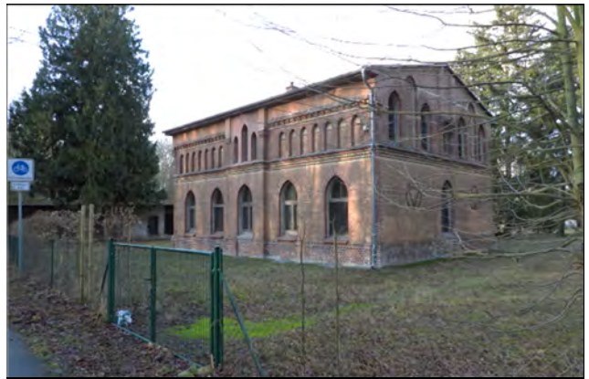
Bedienstetenhaus, Ansicht von Südost (Wohnnutzung)
