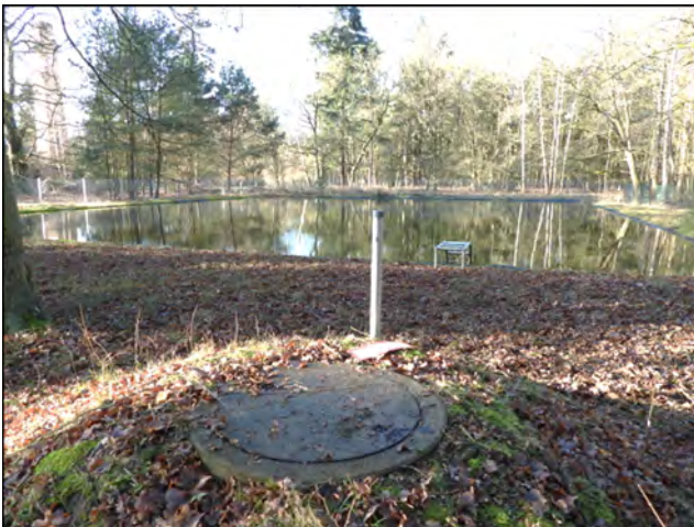
Löschwasserteich und Wasserentnahmestelle, Ansicht von der Straße Sommerswalde (aus Ost)
