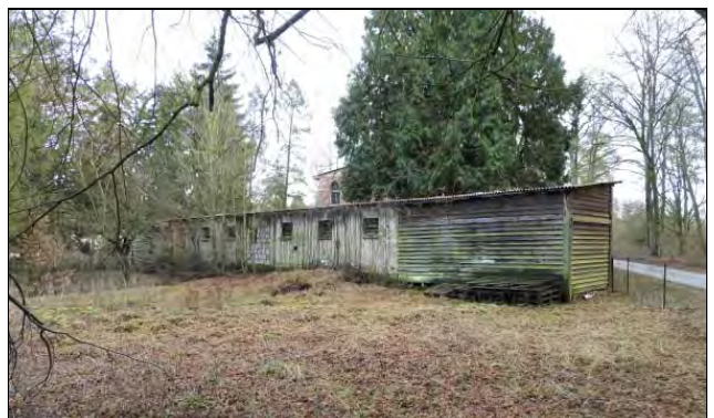
Nebengebäude Bedienstetenhaus, Ansicht von West (von der geplanten Stellplatzfläche, Teilfläche 2)
