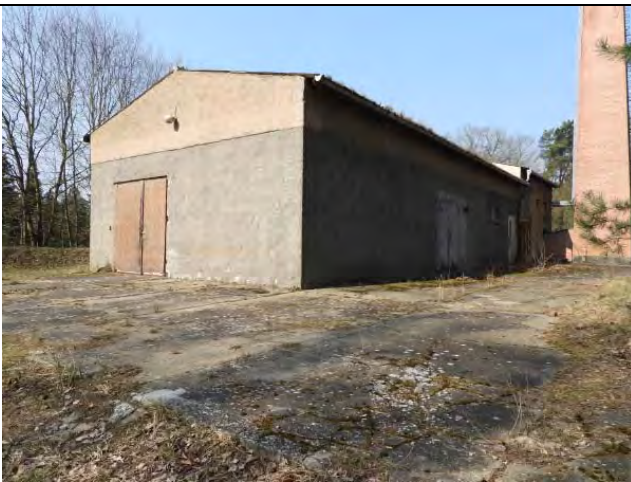
Heizhaus von Ost mit umgebenden Betonflächen
