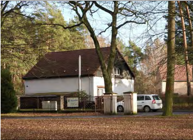
9 Wohnhaus Sommerswalde 5a, Ansicht von West
