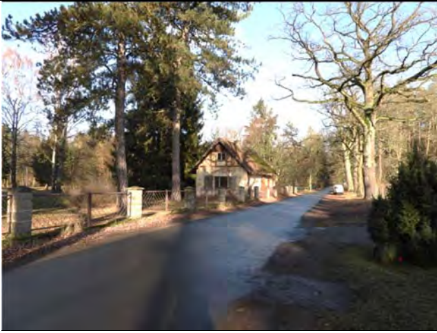
Ehemaliges Backhaus, Ansicht von Süd
