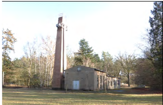
Blick von West zum Heizhaus
