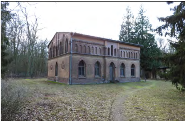
4 Bedienstetenhaus, Ansicht von Nordost (Wohnnutzung)
