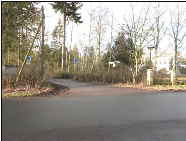
Einmündung der Fahrradstraße Sommerswalde
