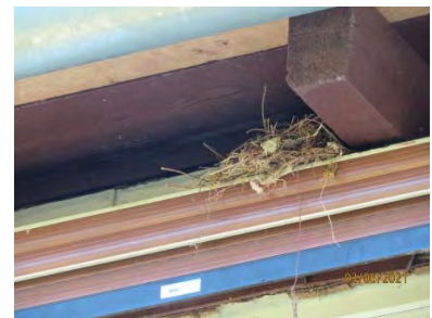
vermuteter Nistplatz Hausrotschwanz am Hauptgebäude, Westseite, Jalousiekasten Fenster OG (2021 nicht genutzt)
