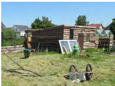
Hühnerstall mit Rauchschwalbenkolonie
