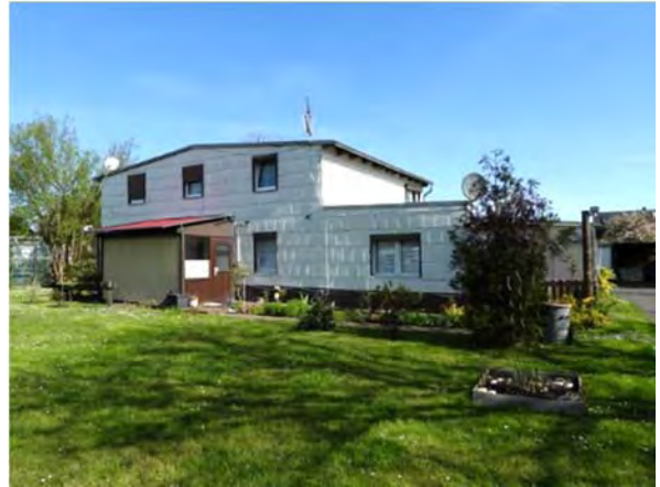
vorhandenes zweigeschossiges Wohnhaus im Plangebiet
