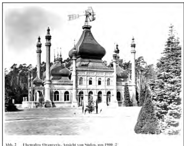
Abb. 2 Ehemalige Orangerie, Ansicht von Süden, um 1900 /2/
