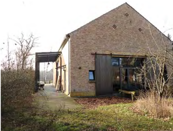
Blick von Nord auf die ehemalige Scheune (3)
