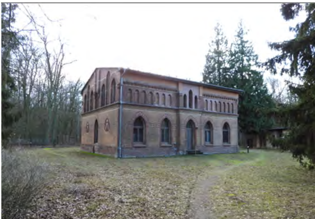
ehemaliges Bedienstetenhaus, Ansicht von Nordost (Wohnnutzung)
