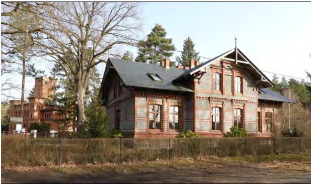
Gemeinsame Ansicht des denkmalgeschützten ehemaligen Forsthauses (1) und des denkmalgeschützten ehemaligen Pferdestalls mit Wasserturm (6)
