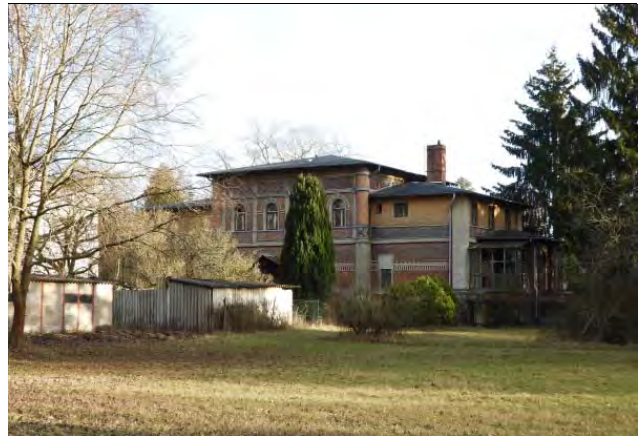
ehemalige Orangerie, Ansicht von West (Wohnnutzung)
