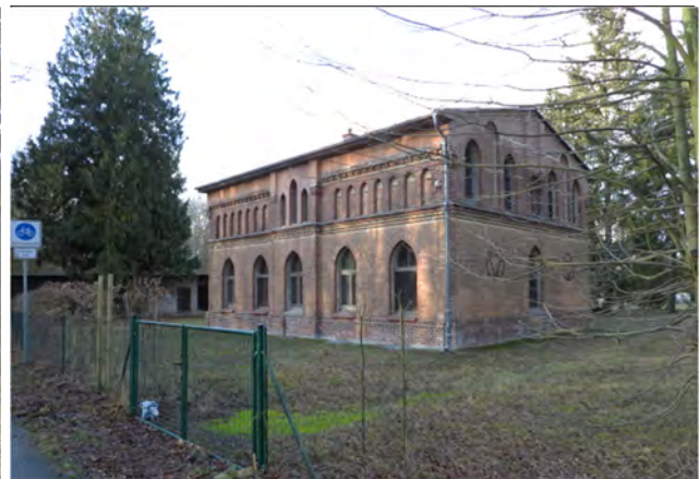
ehemaliges Bedienstetenhaus, Ansicht von Südost (Wohnnutzung)
