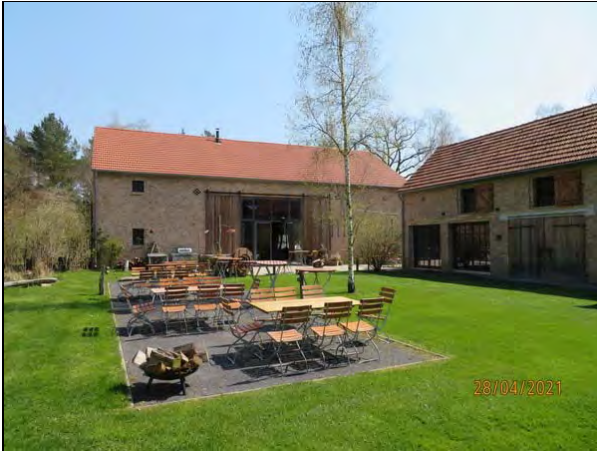
Blick von West, im Hintergrund die ehemalige Scheune (3), seitlich das ehemalige Stallgebäude (2)
