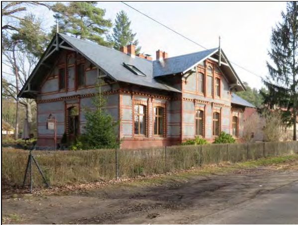
ehemaliges Forsthaus Ansicht von Südwest
