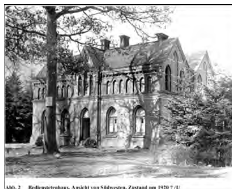
Abb. 2 Bedienstetenhaus, Ansicht von Südwesten, Zustand um 1920 ? /1/
