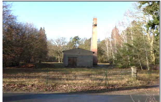
8 Blick von Ost von der Straße Sommerswalde zum ehemaliges Heizhaus (Standort des geplanten Tempels gemäß Bebauungsplan 70/2019 „Buddhistischer Tempel Schloss Sommerswalde“)
