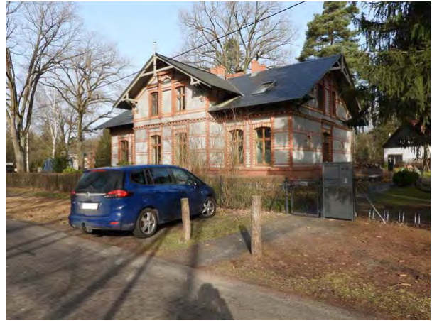
ehemaliges Forsthaus Ansicht von Südost
