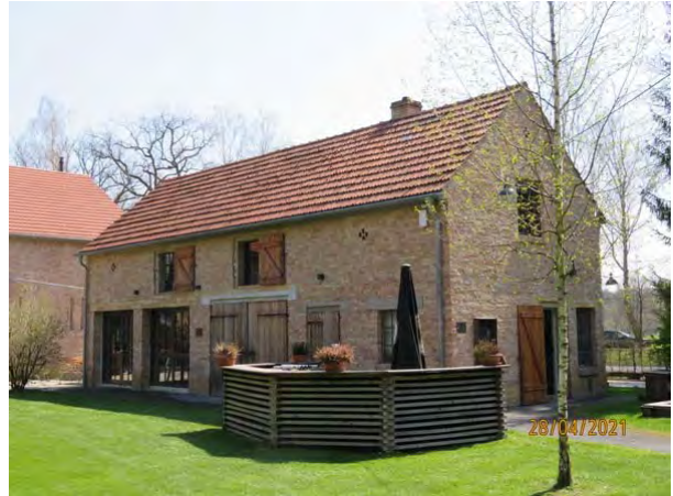
Blick von Nordwest auf das ehemalige Stallgebäude (2)
