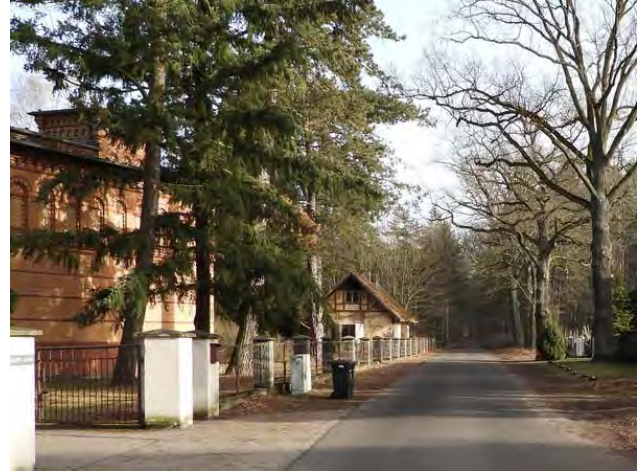
ehemaliger Pferdestall mit Wasserturm (6), Ansicht von Südost Von der Straße Sommerswalde aus ist der ehemalige Pferdestall mit Wasserturm (6) nur eingeschränkt wahr- nehmbar, da teilweise Bäume die Sicht versperren.
