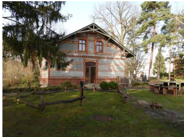
ehemaliges Forsthaus Ansicht von Ost
