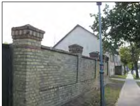
südlicher Teil der vorhandenen Grundstückseinfriedung, Blick nach Süd
