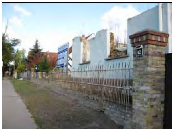
nördlicher Teil der vorhandenen Grundstückseinfriedung, Blick nach Nord
