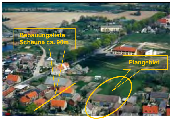
Blick auf das Plangebiet von West, Zustand 1995, vor dem teilweisen Abriss der Bebauung im Plangebiet. Foto Ludwig 1995
