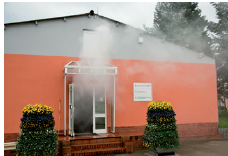
Rauch dringt aus dem Gebäude ...
