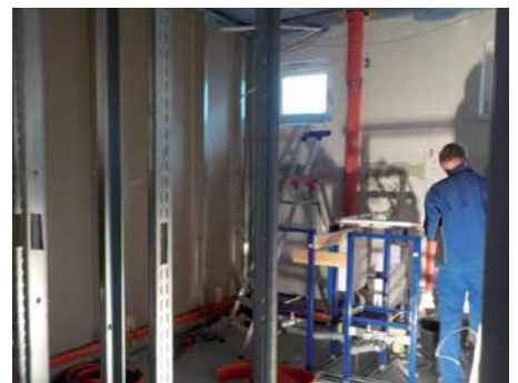
Bauarbeiten in allen Räumen.
