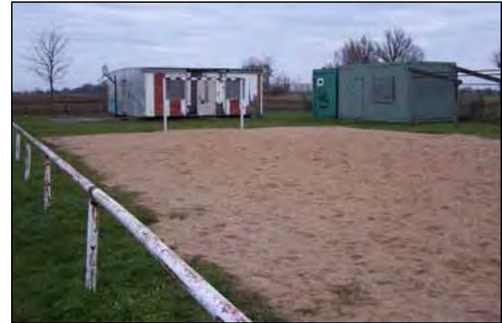
unzureichende Sanitär-Container und fehlende Ballfangnetze am Freizeitsportplatz Eichstädt
