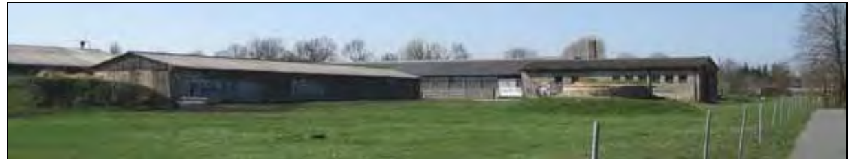
Rinderstallanlage am südlichen Ortseingang von Schwante
