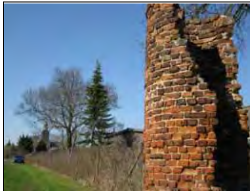
Reste der Umwehrungsmauer der Wasserburg
