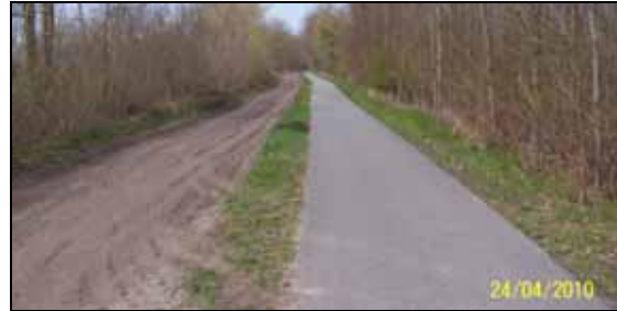
Der Jungferndamm zwischen Hennigsdorf und Schönwalder Straße (L20) ist als Fahrradstraße mit begleitendem Landwirtschafts- und Reitweg komfortabel ausgebaut. Er leitet zunehmend Naherholung Suchende in Richtung Bötzow.
