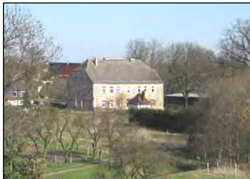
Das Amtshaus von 1786
