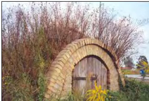
alter Eiskeller an der Regionalbahnstation
