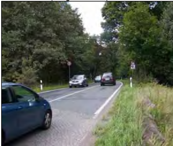
stark befahrene Straße Hennigsdorf-Marwitz (Landesstraße L17) Ein straßenbegleitender Radweg wurde 2013 realisiert.
