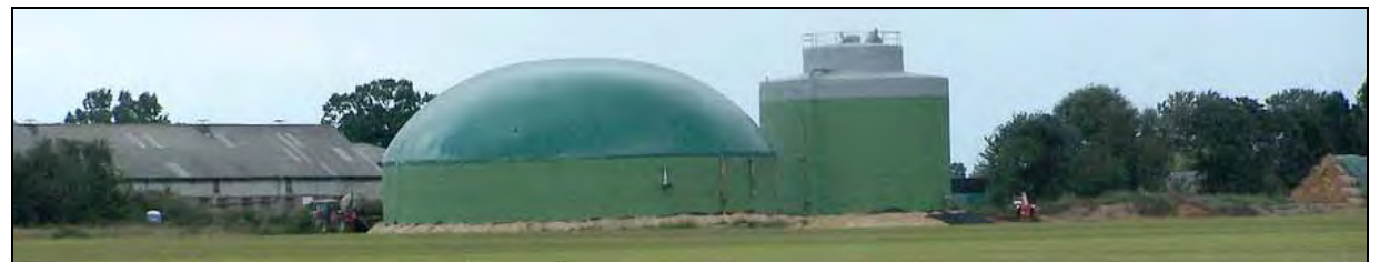
Bio-Gas-Anlage südöstlich von Eichstädt
