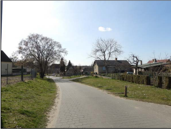
Westlicher Teil des Schäferweges, Blick nach West
