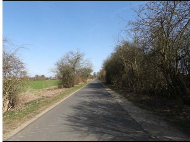
westlicher Schäferweg Blick nach Ost
