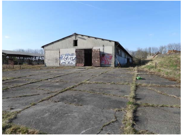
Betonfläche südlich des nördlichen Stallgebäudes
