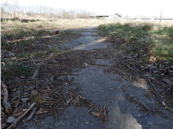
Zufahrtweg vom Tor Richtung Nordost
