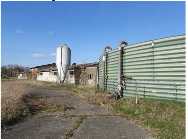
Güllebehälter, Silo, östliches Stallgebäude, Blick von Süd
