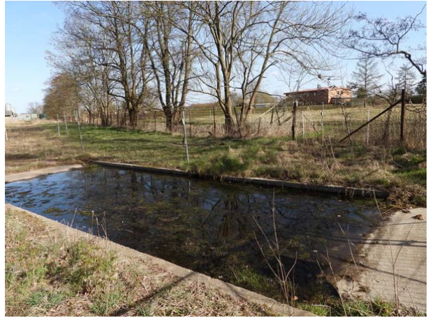
Seuchenwanne an der Zufahrt, Blick von Nordwest
