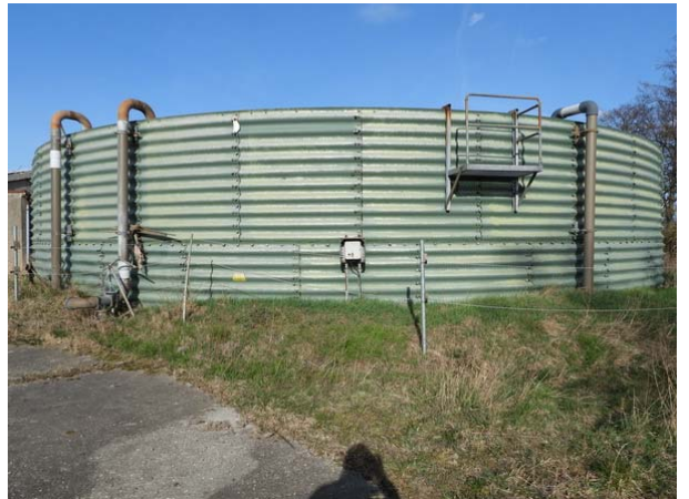
Güllebehälter im Südosten der Sauenanlage
