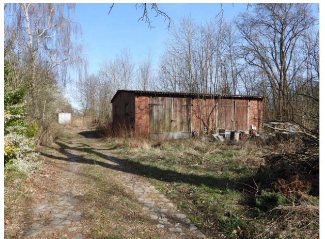
Östlicher Teil der Straße Koppehof, Blick nach Ost in Richtung der Zufahrt zur ehemaligen Sauenanlage
