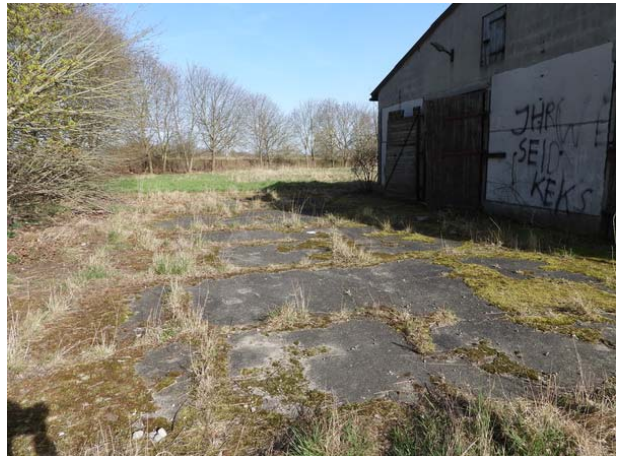
Betonfläche nördlich des nördlichen Stallgebäudes
