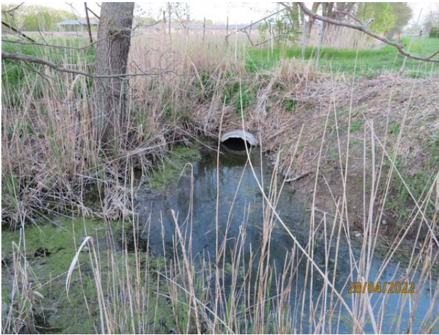
Elsgraben südlich der ehemaligen Sauenanlage, Blick von der Grabenmündung Tränkegraben Richtung Ost. Der Elsgraben weist hier eine zusätzliche Verrohrung auf
