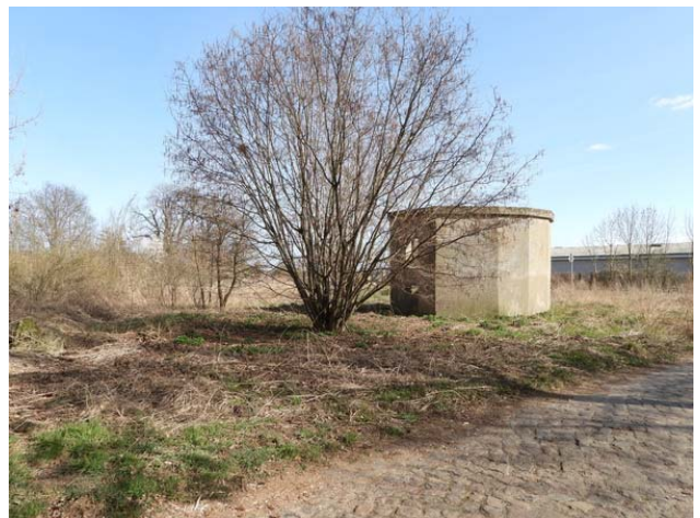
Silo im Südwesten der Fläche, Ansicht von der Straße Koppehof
