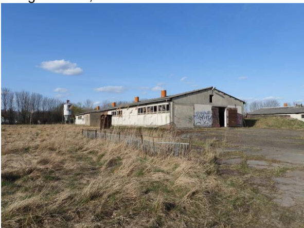
Nördliches Stallgebäude, Blick von Südwest
