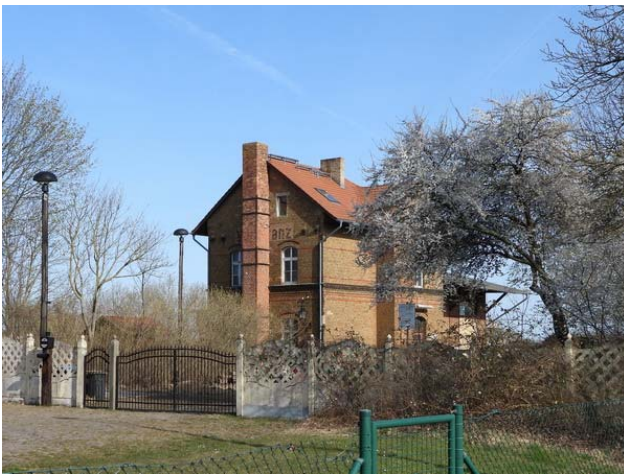
Blick nach Südost auf das ehemalige Bahnwärterhaus
