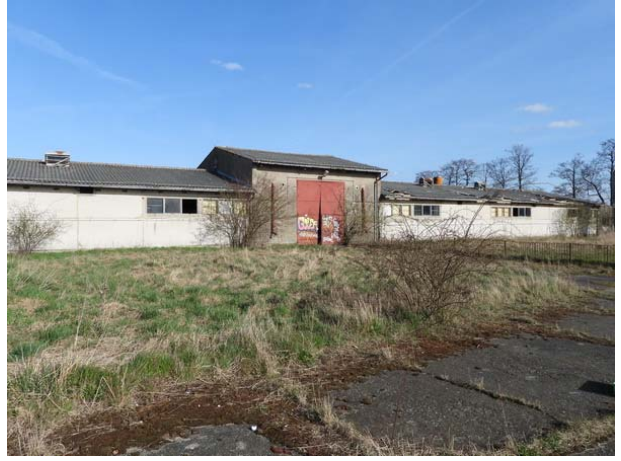
Blick von West auf das östliche Stallgebäude
