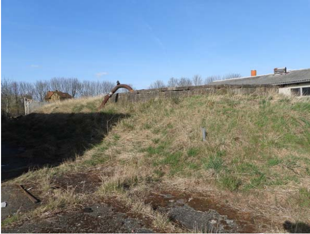
Güllebehälter östlich des nördlichen Stallgebäudes
