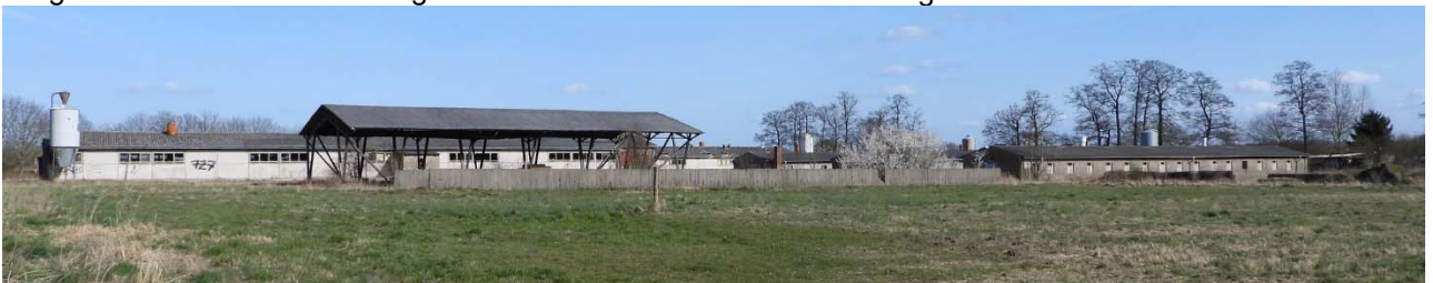
Gesamtansicht von West, Bergehalle und Stallgebäude
