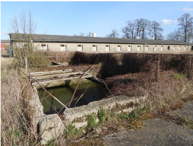
Güllebecken nordwestlich der südlichen Stallgebäude
