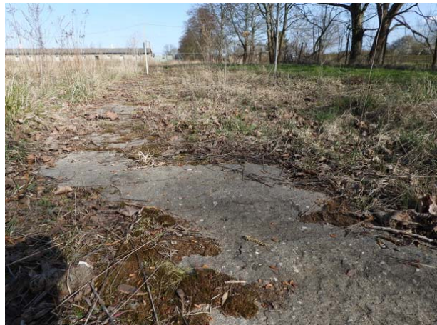
Zufahrtweg vom Tor Richtung Ost
