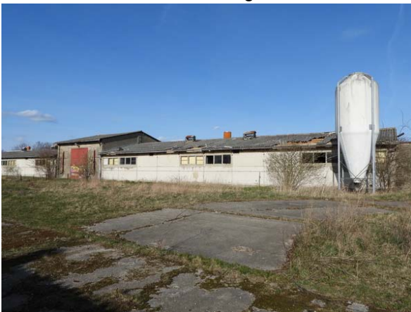
Südlicher Teil des östlichen Stallgebäudes, Blick von West
