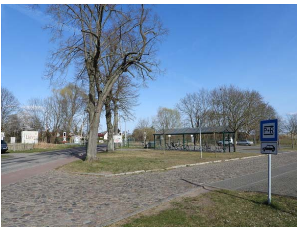
Einfahrt von der Bärenklauer Straße zum Vorplatz des Regionalbahnhaltelpunktes, Blick nach Ost
