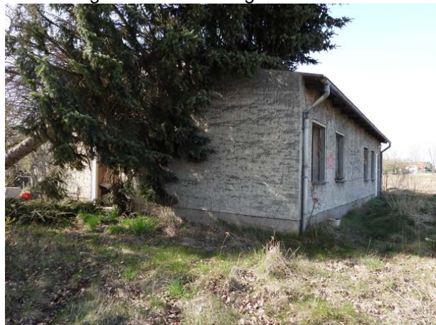
Bürogebäude mit 2022 umgekippter Fichte
