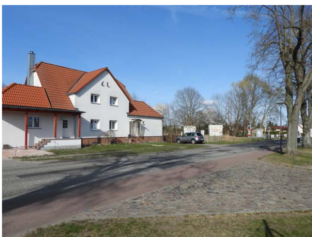
Zufahrt Bärenklauer Straße / Bahnhofvorplatz, Blick Richtung des ebenerdigen beschränkten Bahnüberganges der Regionalbahn
