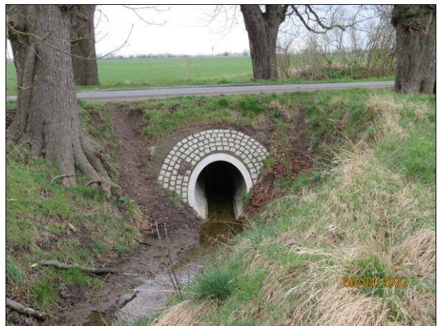
Grabendurchlass Koppehofer Feldgraben
