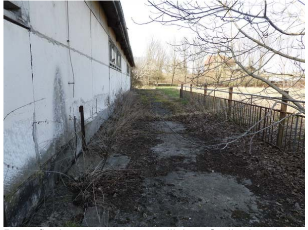
Betonfläche östlich des nördlichen Stallgebäudes
