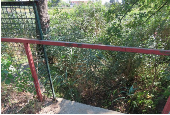
Abb. 4: Eisgraben an der Zufahrt
