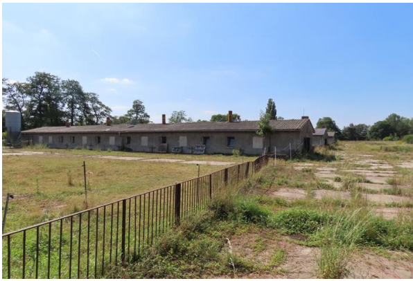
Abb. 12: Ställe im Zentrum des Untersuchungsgebietes
