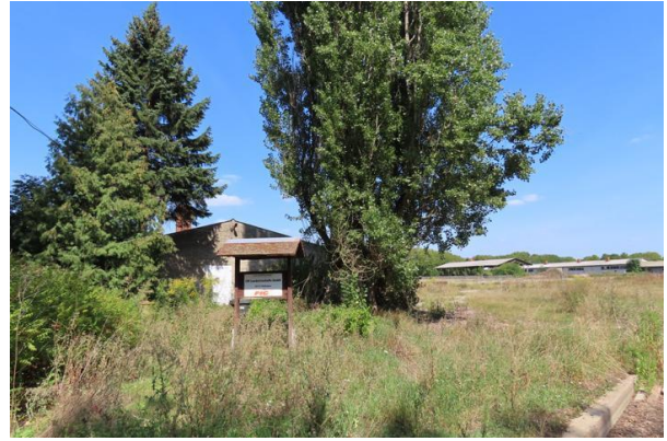
Abb. 5: Eingangsbereich zur Stallanlage im Westen
