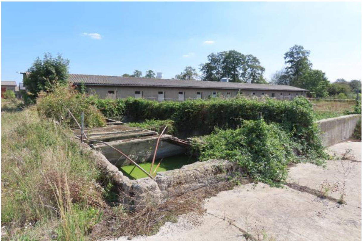
Abb. 28: Wasserbecken auf dem Grundstück
