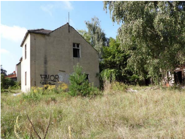
Wohngebäude Veltener Str.79
