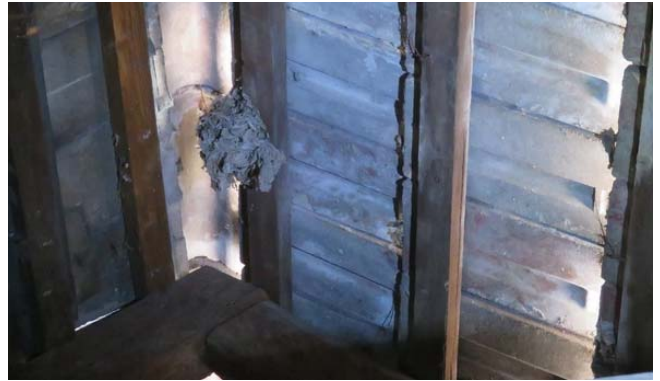
Spitzboden mit älteren Resten eines Wespennestes
