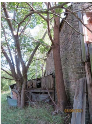
Gehölzaufwuchs im Fundamentbereich Nebenglass Acer platanoides
