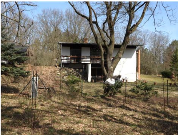
Wohngebäude zur Tischlerei im Nordwesten des Plangebietes
