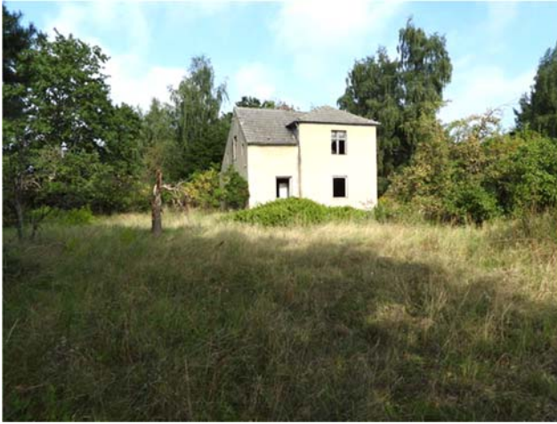
Wohngebäude Veltener Str.79
