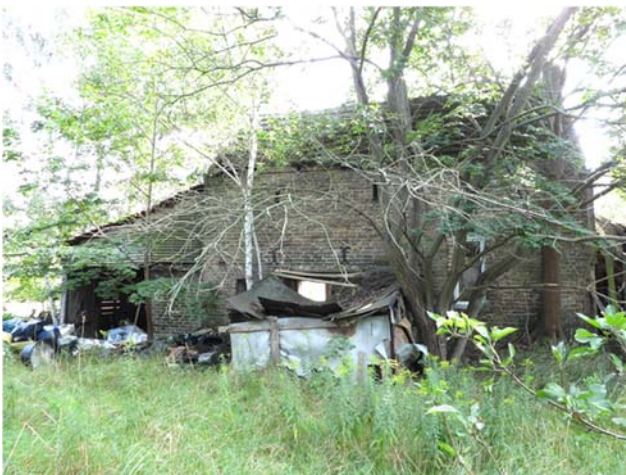
Nebengebäude mit Müllablagerungen
