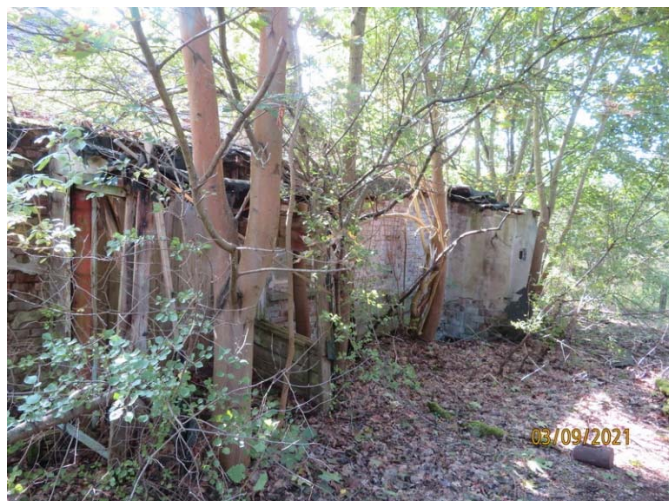
Bäume, am Fundament des Abbruchgebäudes aufgewachsen
