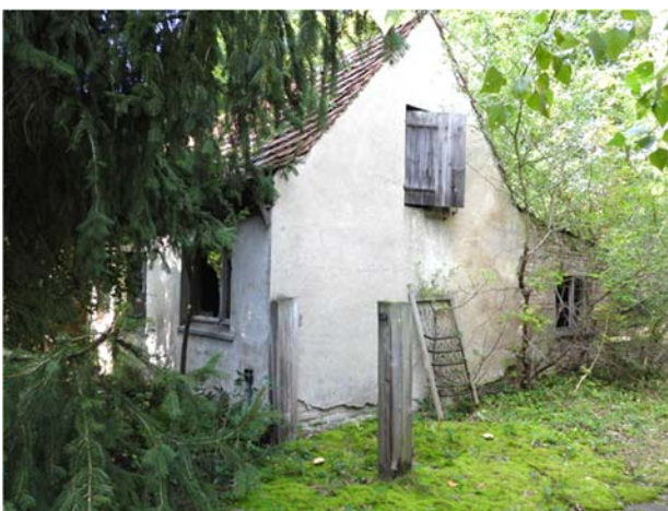
Wohngebäude Veltener Str.83
