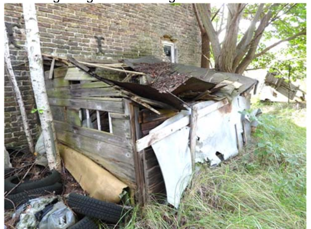
Müllablagerungen an Nebengebäude
