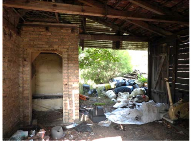
Müllablagerungen in Nebengebäude
