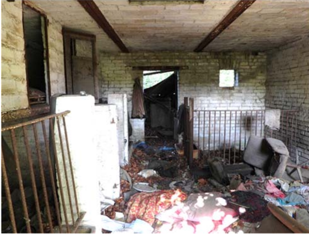
Müllablagerungen in Nebengebäude
