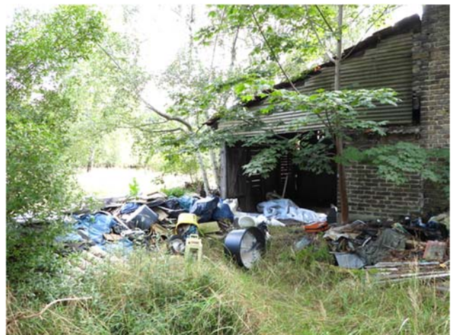
Nebengebäude mit Müllablagerungen
