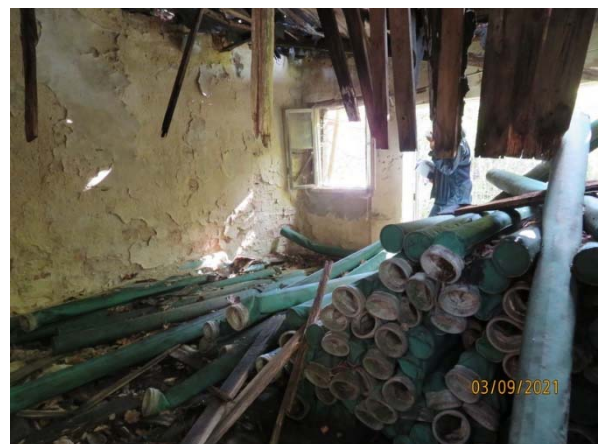
Nebenglass Flst.72 – Innenbereich mit teils eingestürzter Decke – gelagerte Dränagerohre
