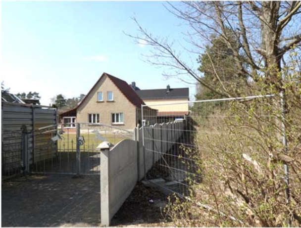
Wohnbebauung Bergstraße / Ecke Veltener Straße angrenzend an das Plangebiet
