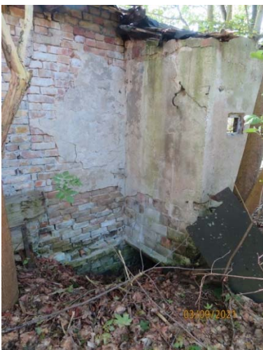
Abtritt am Hauptgebäude Flst.72
