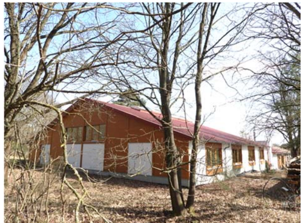
Tischlerei nördlich des Plangebietes, nördlicher Teil
