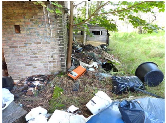
Müllablagerungen an Nebengebäude
