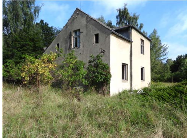
Wohngebäude Veltener Str.79
