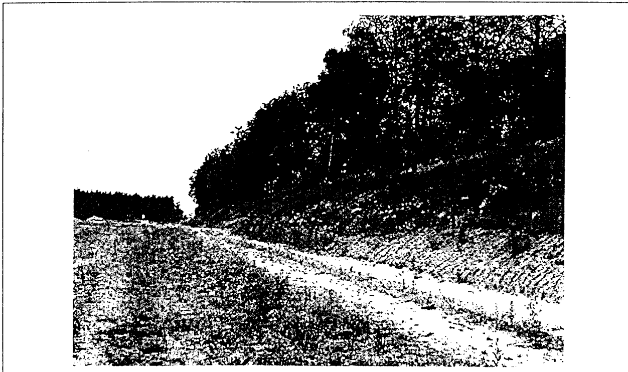
Foto: Blick entlang der Südseite des Dammes in Richtung Nordwest
