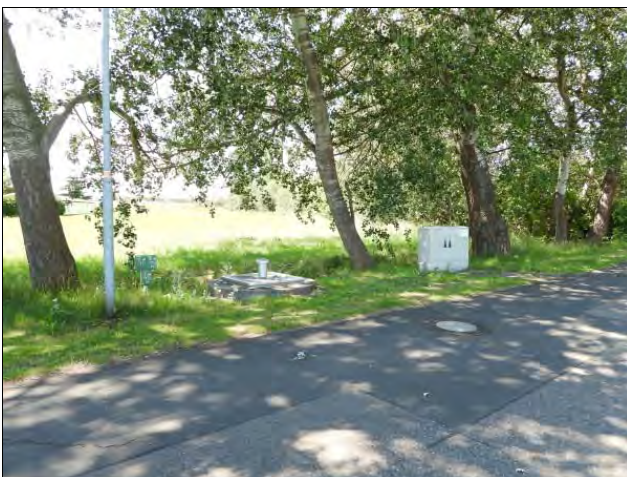
Abwasserpumpwerk auf der Südwestseite des Bahnweges im mittleren Bereich des Plangebietes
