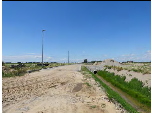
Blick zum Anschluss Veltener Weg (im Ausbau) aus Richtung Bahnweg (Foto 06/2020)
