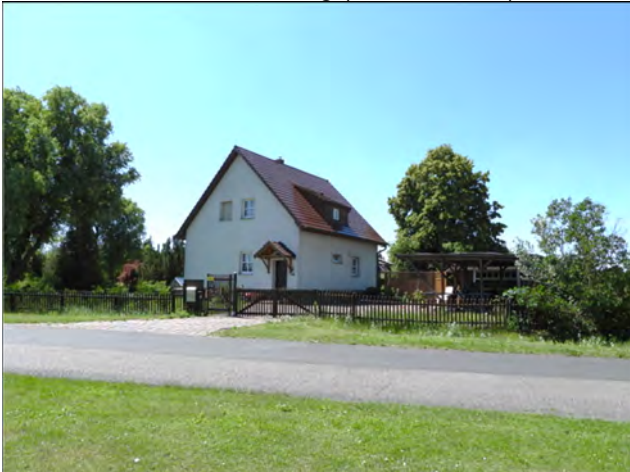
Wohnbebauung südwestlich Bahnweg (Foto 06/2020)
