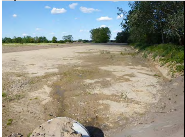
Regenrückhaltebecken im Gewerbepark Vehlefanz angrenzend an das Gewerbegebiet Bärenklau (Foto 06/2020) Blick in Richtung Ost.
