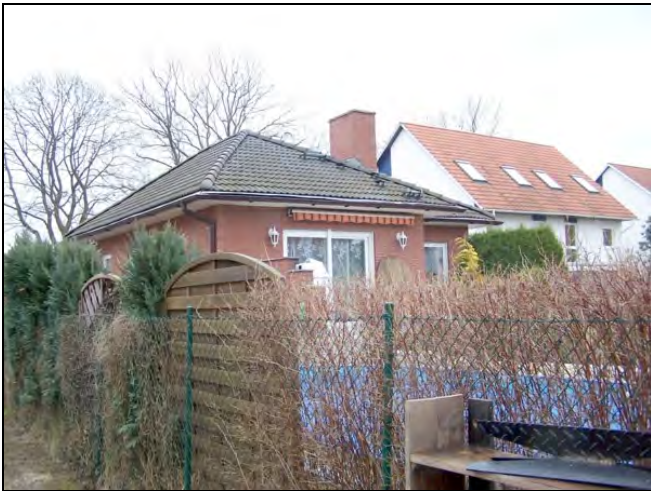
im Vordergrund Wohnhaus Flurstück 29/2 (im Plangebiet) mit angrenzender Bebauung „Am Heidewinkel“
