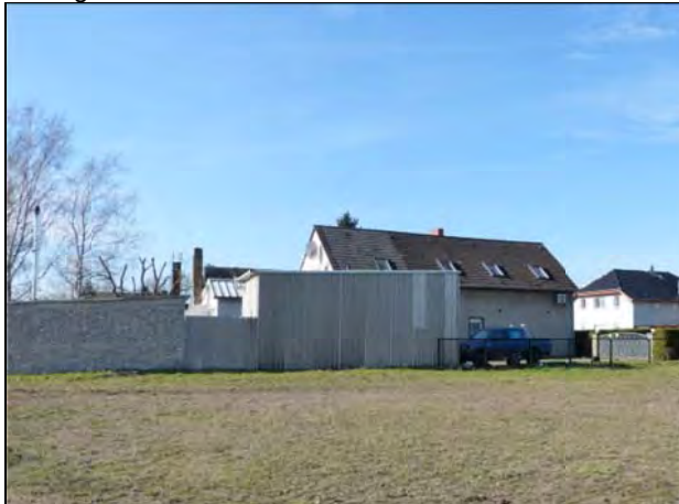
Bebauung südlich angrenzend an das Plangebiet
