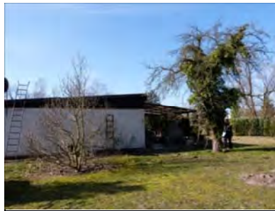
Erholungsgarten-Brache im Nord-osten des Plangebietes
