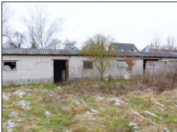
Wirtschafts- und Nebengebäude, mittlerer Teil, Ansicht von Nord
