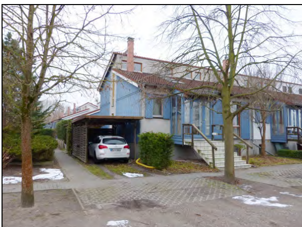
Reihenhäuser südwestlich des Plangebietes
