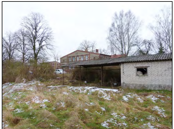
Wirtschafts- und Nebengebäude, östlicher Teil, Ansicht von Nord
