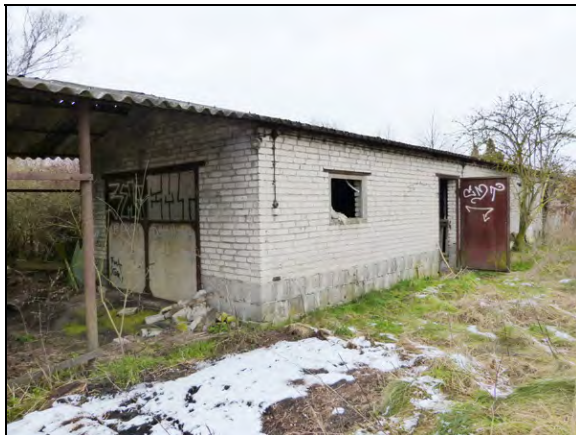
Wirtschafts- und Nebengebäude, Ansicht von Nordost
