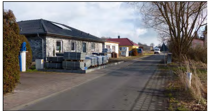
weitere (neue) Wohnbebauung am Mittelweg (Blick nach NO)
