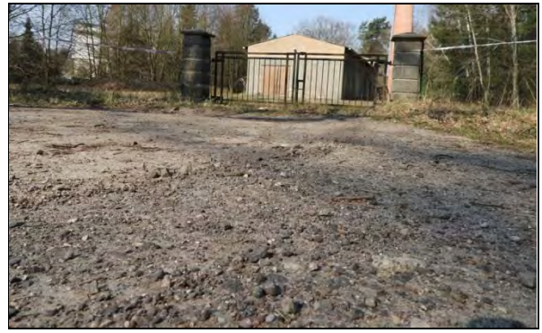
Teilbefestigte Fläche Schotter
