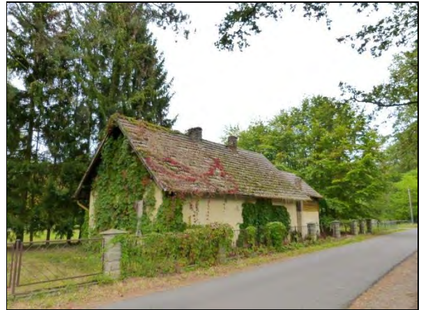
Gebäude (geplanter Abbruch) ehem. Backhaus
