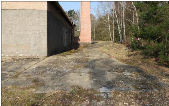
Befestigte Fläche - Beton
