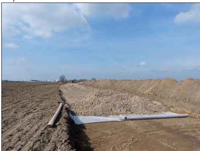
Trasse Veltener Weg mit bereits hergestelltem Unterbau (südlicher Teil – Blick nach West) - März 2019
