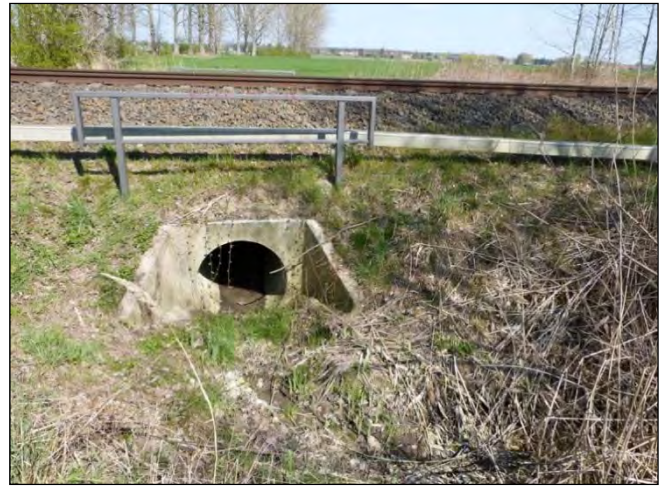
Graben L 085 im SO des Plangebietes Unterführung unter die Kremmener Bahnstrecke in Richtung Bärenklau
