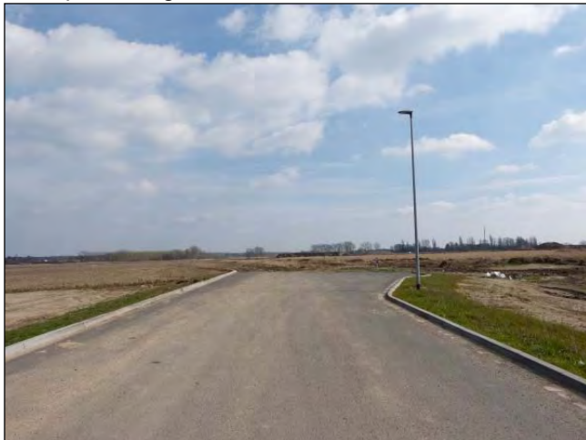
Blick in die kurze Stichstraße in Richtung Ost
