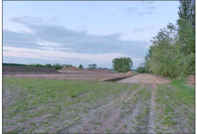
Blick in Richtung Südost über die im Bau befindliche Regenwasserretentionsfläche – Mai 2019
