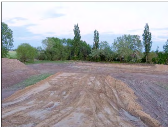
Östlicher Rand der im Bau befindlichen Regenwasserretentionsfläche – Blick aus Nord – Mai 2019
