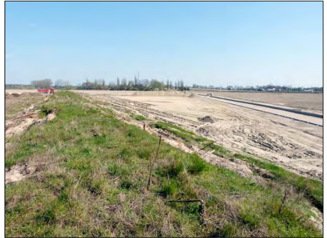
Reste des ehemaligen Erdwalls nördlich des Veltener Weges (außerhalb der Planänderungsfläche) Blick nach SO Im Bild rechts: Veltener Weg, noch ohne Asphaltdecke und ohne RW-Mulde
