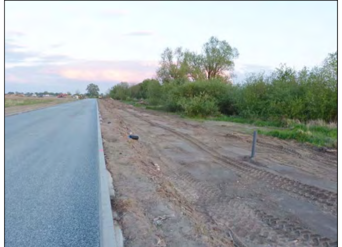
Blick von Nord in den im Bau befindlichen Veltener Weg Mai 2019
