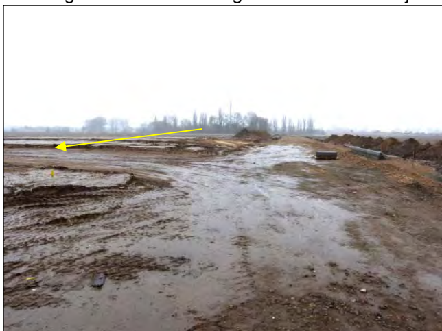
Der Pfeil kennzeichnet die Lage der Abzweigung des Erschließungsstiches vom im Ausbau befindlichen Veltener Weg. – Foto: April 2019
