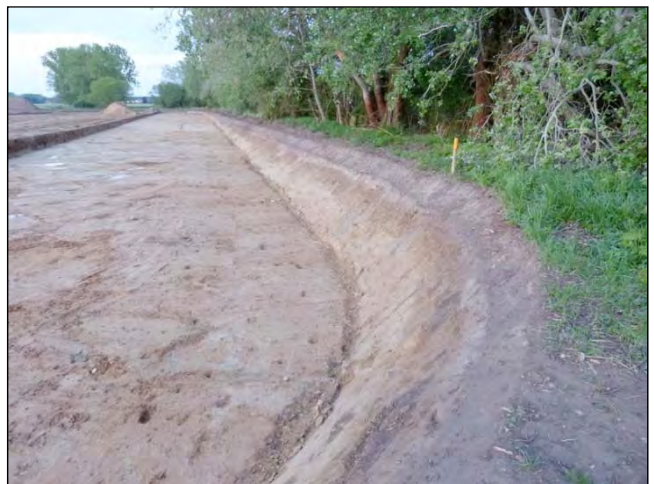
Blick in Richtung Ost über die im Bau befindliche Regenwasserretentionsfläche – Mai 2019
