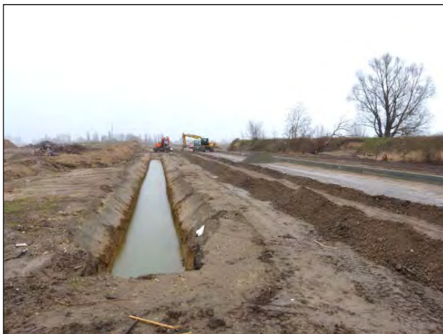
Blick von Nordwest in den im Bau befindlichen Veltener Weg mit Niederschlagsentwässerungsmulde (südöstlicher Teil)
