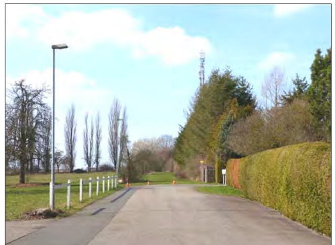
Bisheriges Ausbauende des Veltener Weges auf der Gemarkung Bärenklau, Blick nach NW in Richtung der bisher noch nicht ausgebauten Fortführung des Veltener Weges in Richtung Gewerbepark Vehlefanzt
