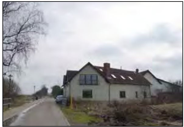
Bebauung östlich des Grabens auf der Südseite des Veltener Weges, Blick von West aus Richtung Plangebiet
