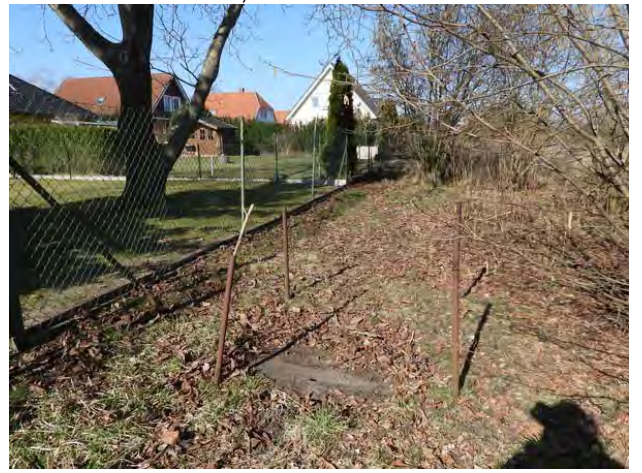
kommunales Flurstück (ca. 3m breit) mit verrohrtem Graben entlang der westlichen Plangebietsgrenze mit Schachtdeckel des verrohrten Grabens im mittleren Bereich angrenzend an das Plangebiet, Schacht mit viereckigem Deckel
