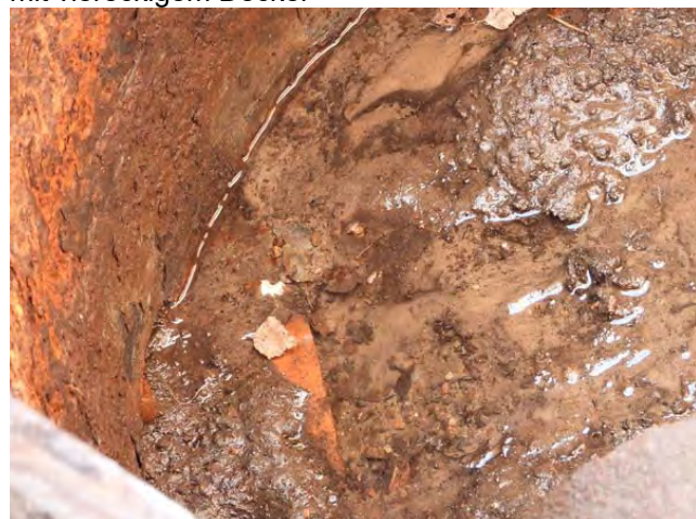
gleicher Schacht des verrohrten Grabens mit versandetem Rohrauslauf in Verlaufsrichtung des Grabens (Schacht mit viereckigem Deckel)
