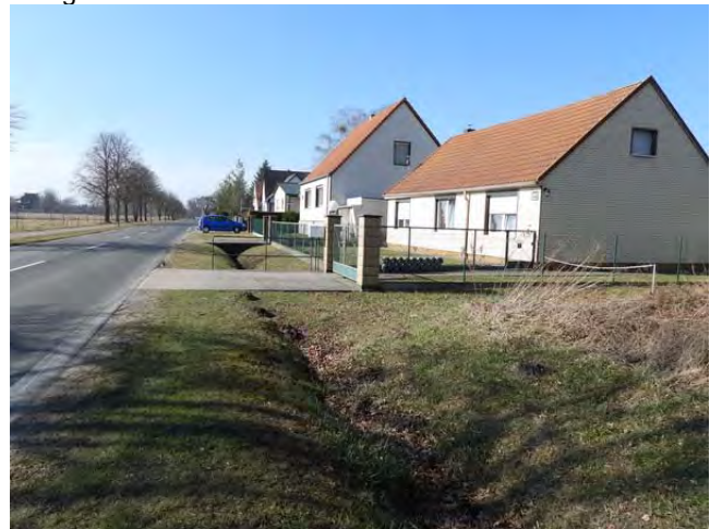
Im Bereich der Grundstückszufahrten an der Bärenklauer Straße ist der straßenbegleitende Graben jeweils verrohrt
