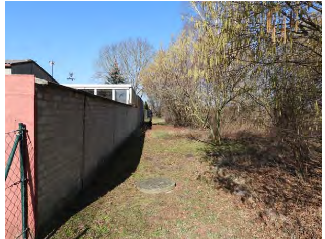
kommunales Flurstück (ca. 3m breit) mit verrohrtem Graben entlang der westlichen Plangebietsgrenze mit Schachtdeckel des verrohrten Grabens nahe der Bärenklauer Straße, Schacht mit rundem Deckel
