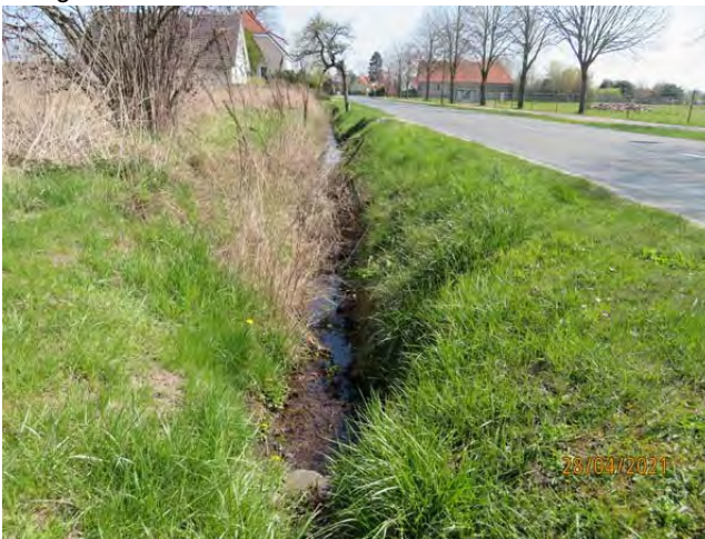
Grabenaustritt nördlich der Bärenklauer Straße, über den auch das Wasser aus dem verrohrten Graben westlich des Plangebietes abläuft
