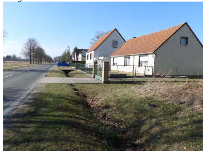
Im Bereich der Grundstückszufahrten an der Bärenklauer Straße ist der straßenbegleitende Graben jeweils verrohrt
