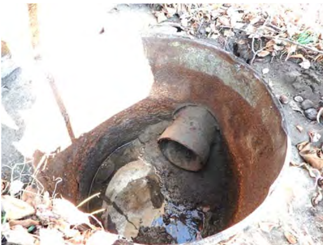
geöffneter Schacht des verrohrten Grabens im mittleren Bereich des Plangebietes mit Zulaufrohr aus Richtung des Plangebietes (Schacht mit viereckigem Deckel)
