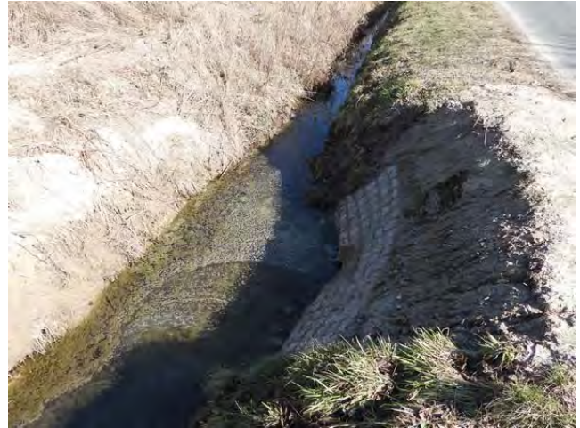
Grabendurchlass unter der Bärenklauer Straße vor dem Plangebiet
