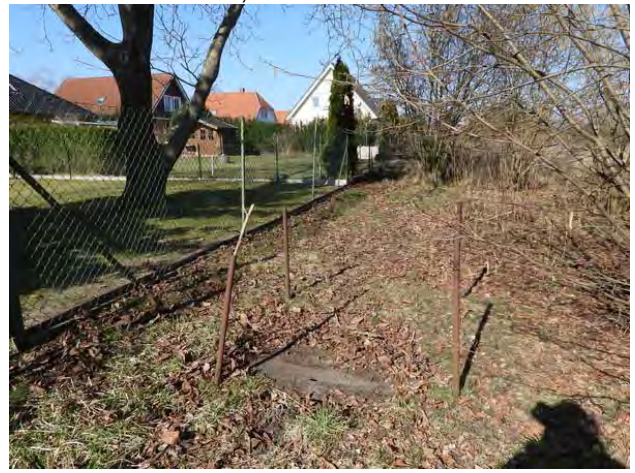
kommunales Flurstück (ca. 3m breit) mit verrohrtem Graben entlang der westlichen Plangebietsgrenze mit Schachtdeckel des verrohrten Grabens im mittleren Bereich angrenzend an das Plangebiet, Schacht mit viereckigem Deckel
