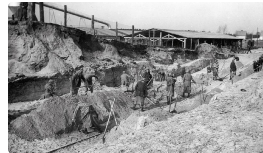
Häftlinge des KZ Ravensbrück bei Erdarbeiten zur Erweiterung des Lagers, vermutlich 1940
