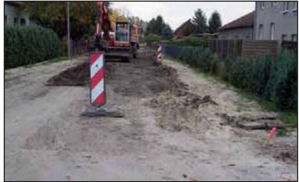
Im zweiten Bauabschnitt (von Bahnstraße bis Sauerholzweg) schreiten die Bauarbeiten voran. Im Anschluss an die Errichtung der Zufahrten wird Anfang November die Schwarzdecke aufgetragen.
