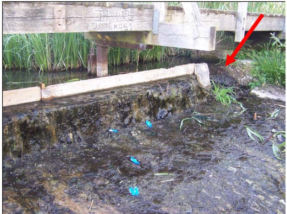
Als erste Maßnahme zur Verbesserung der Wasserqualität im See ist geplant, das **nährstoffreiche Tiefenwasser** aus dem Westteil des Sees mittels einer offenen Rohrleitung am Grunde des Sees zum Überlauf zu führen. Im Zusammenhang mit der Installation dieses Tiefenwasserüberlaufs soll die **Dammkrone** am vorhandenen Überlauf erneuert und geringfügig erhöht werden.
